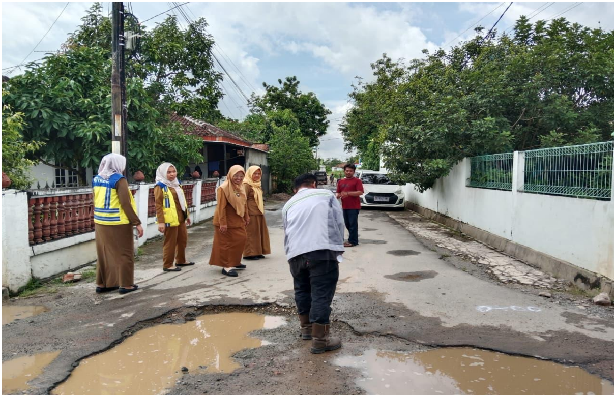
Pengukuran ulang jalan
